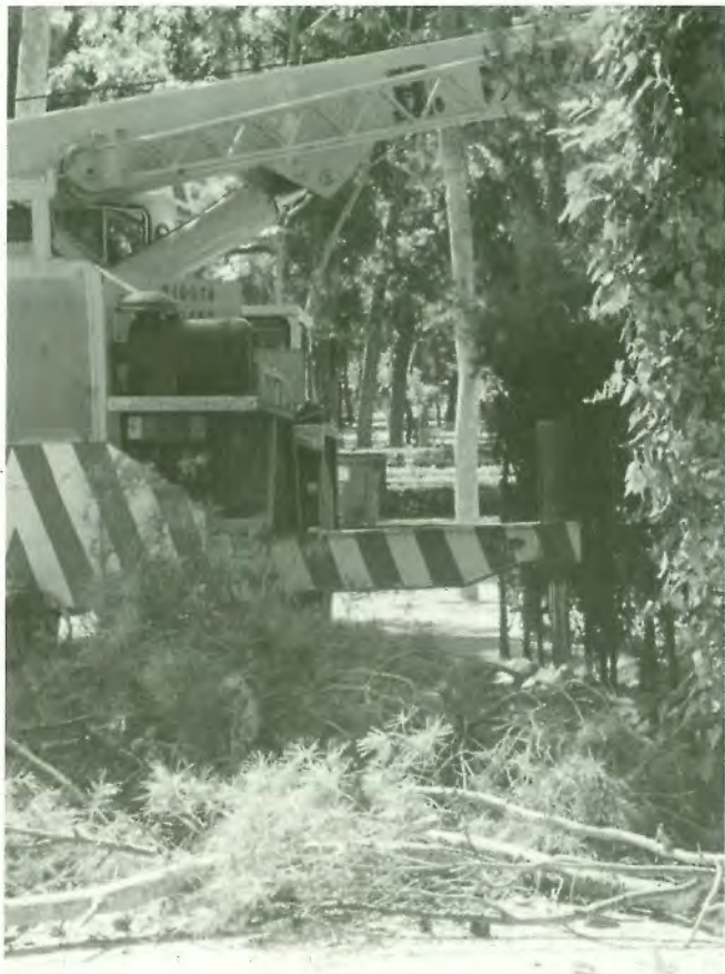
Obras en el Parque.
